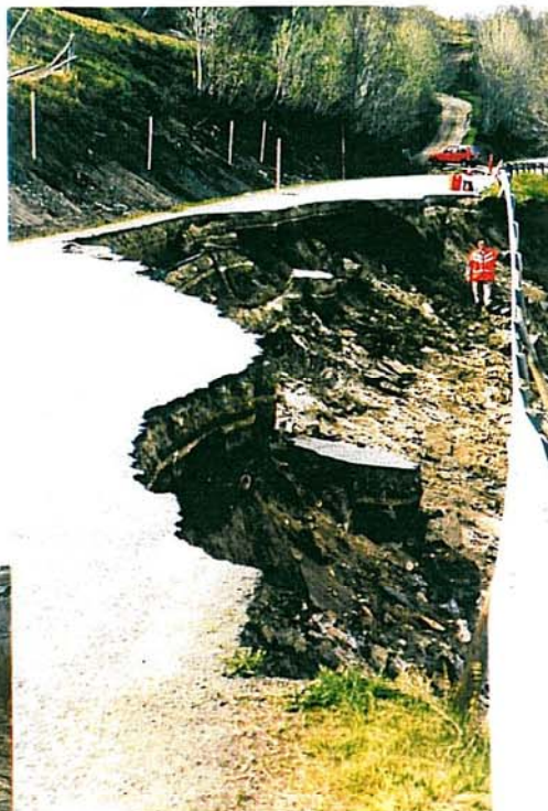
Rv. 858, utglidning i Malangen. Vegen var stengt i ca. 14 dager. Reparasjonen koster ca. 850.000
