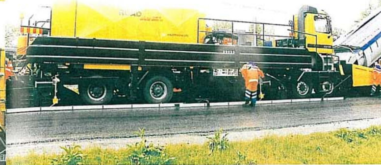
Utlegger og fres tilsetter bitumen (bindemiddel) og ny asfalt.
