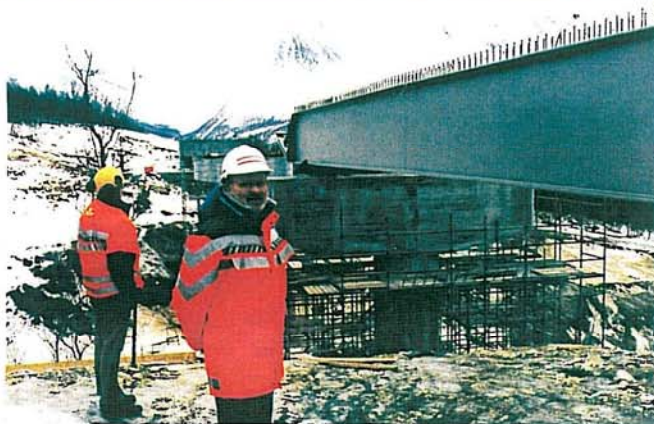
Prosjektleder Ingvar Øvereng og utbyggingsjef Stein Johansen betrakter lanseringen av stålbjelkene ved Kvitbergelva bru.
