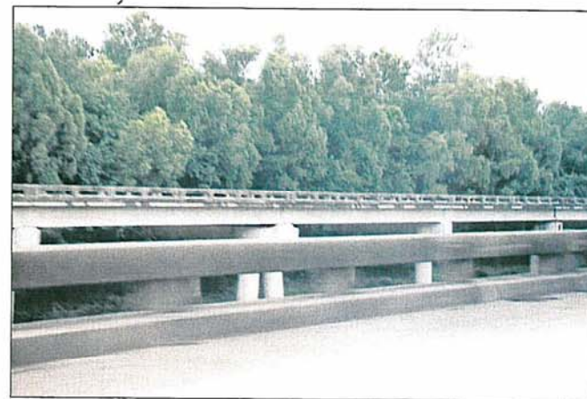
Highway? - bygd på pæler gjennom utallige mil med sump.
