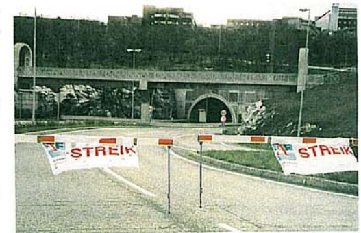
Tromsøysund- og Breivikatunnelen ble stengt fredag 5. juni kl. 14.00 i mangel av beredskap - noe som førte til kostning ut av byen og flere timer venting for bilistene.
