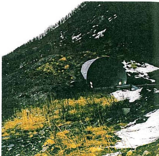
«Løsmassetunnel» på fjordgårdsveien (fv. 275). Stålrør overfylt med løsmasse skal sørge for at raset går over tunnelen. Effektivt, men ikke særlig vakkert.
