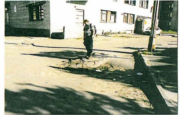
Geir Berntsen betrakter setningsskader i vegen.
