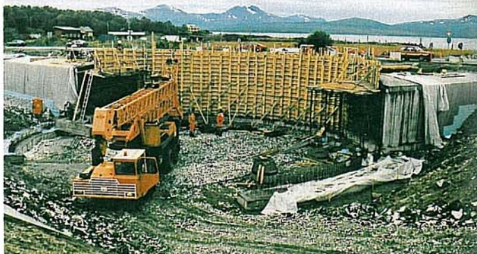
Bygging av undergang i Giæverbukta.
