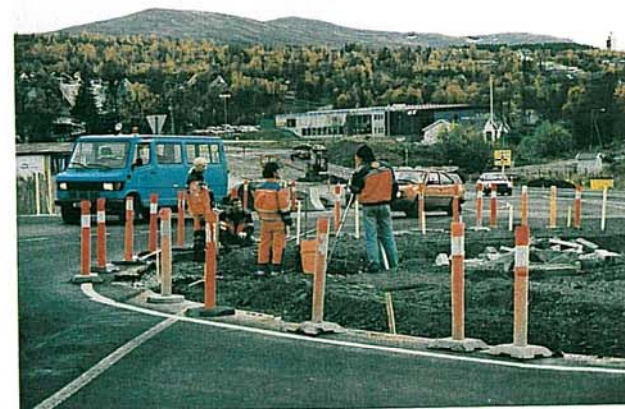
Vegarbeidet pågår tett inn i trafikken.
