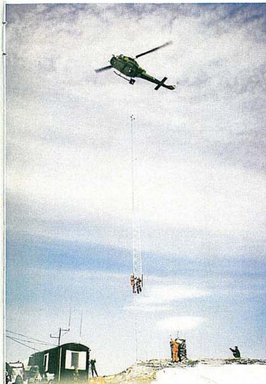
Montasje av mast i Bardu
