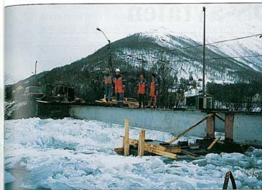
Furuflaten bru. Elva flommer over og ismassene presser på brua
