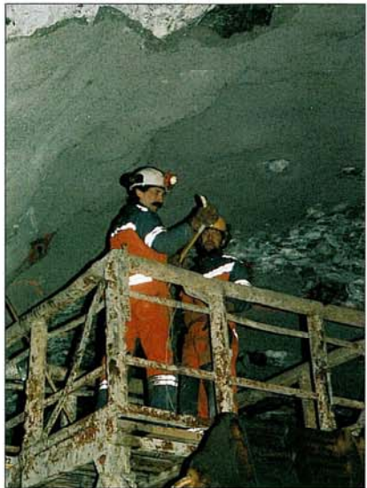
Strossing av betongtaket. Sigmund Johnsen og Åsmund Ellefsen.
