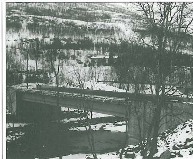
Ny bru i Løksebotn på tilførselvegen til Mjøsundbrua.
