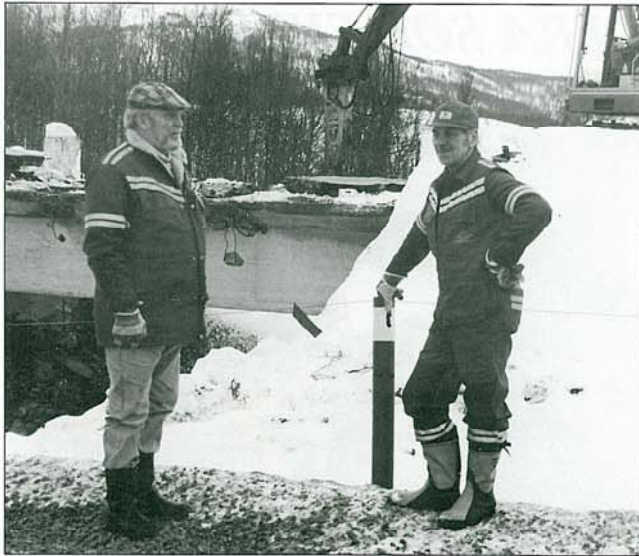
Ny bru over Skarelv på E-6. Agnar Hansen og Thor Stenseth betrakter det som er igjen av gammelbrua.
