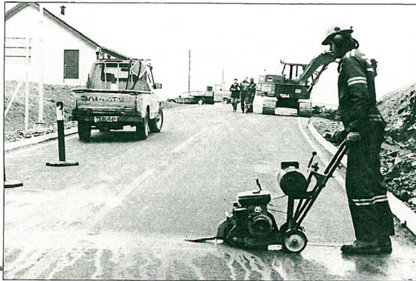
De siste arbeidene med rassikringstunnelen på Kågen.
