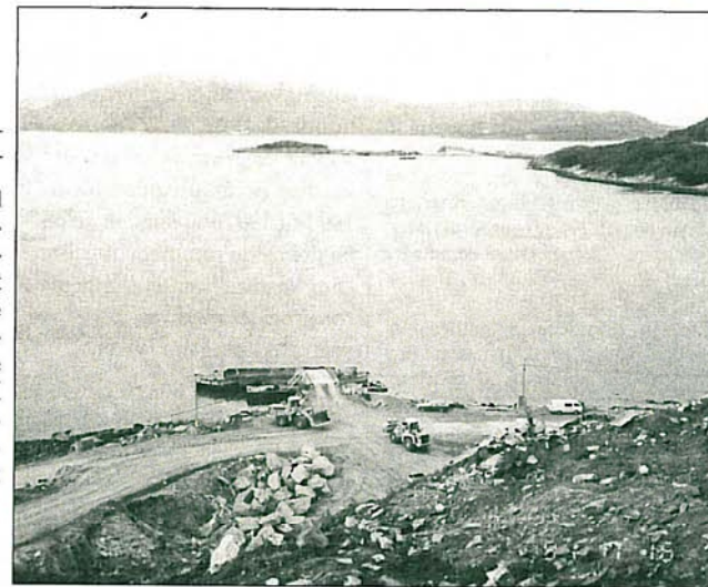
Lasting av lekter over flytekaia ved sidetaket. Fyllinga vises i bakgrunnen.
