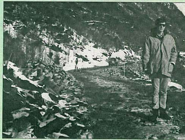
Anleggsleder Toralf Bergseth — med deler av anlegget i bakgrunnen.
