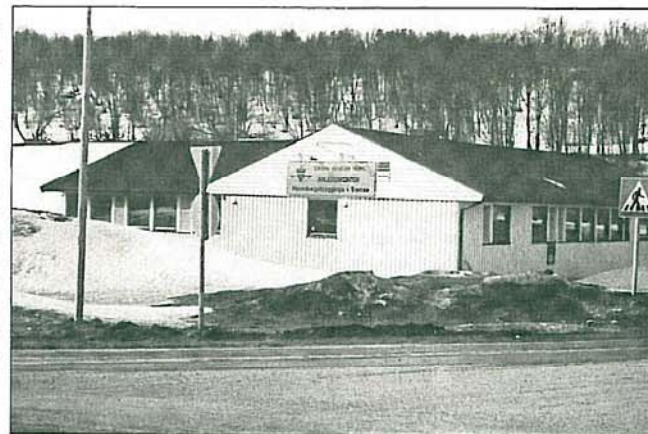
Anleggskontoret til hovedvegutbygginga i Breivika.
