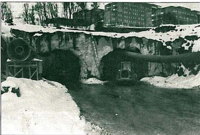
Tunnelen under RITØ er en realitet
