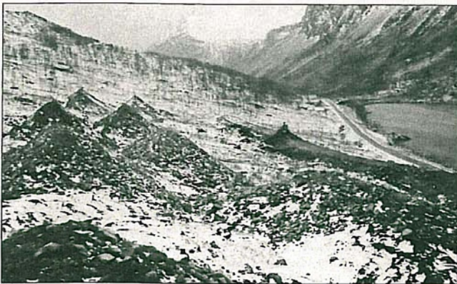
Bremsekjeldene skal hindre snøen i å nå riksveg 864.
