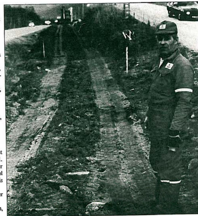
Gang- sykkelveg på rv. 855, Finnjordbotn - Fagernes skal fullføres i 1991 - Hans Hansen ved anlegget.
