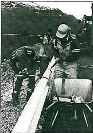
Arbeid med rekkverkoppsetting på rv. 84.
