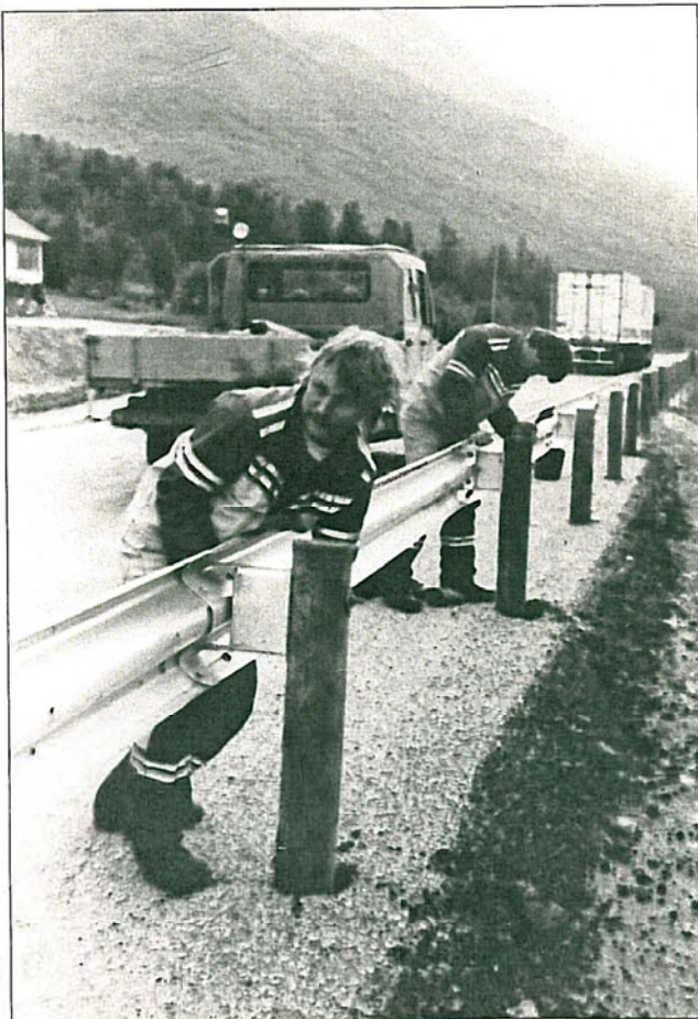
Blant etterarbeidene på E-78 i Lavangsdalen gjenstår det en del rekkverksoppsett.
