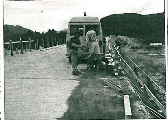
Rekkverkoppsett på den nye Bergmo bru.
