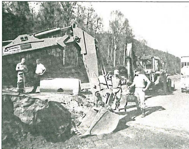
Det eneste anleggsarbeid som pågår for tida i området er bygging av gang/sykkelveg fra Elverum vegdele til Bardufoss videregående skole.
