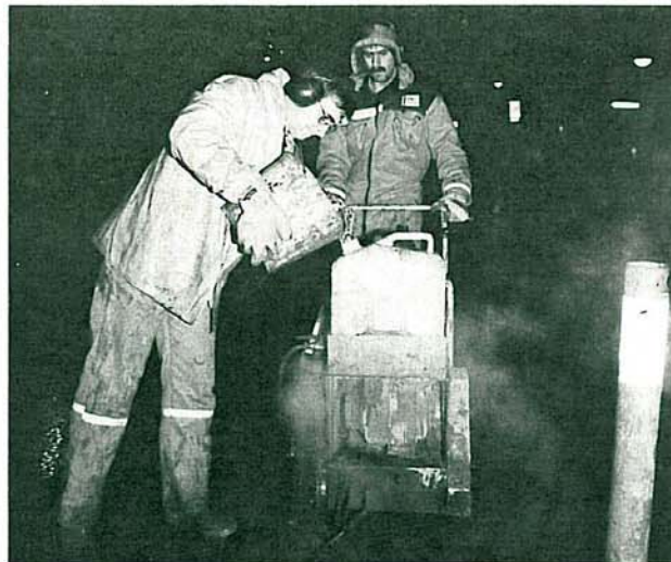
Petter og Rolf i asfalskjæring en sen høstkveld.
