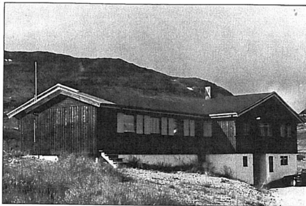
Et av våre innbydende «fritidshus» — Brøytestasjonen på Kvænangsfjellet. Foto: Tor Fr. Holan.
