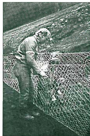
Sigurd og Torstein jobber med gabionene.
