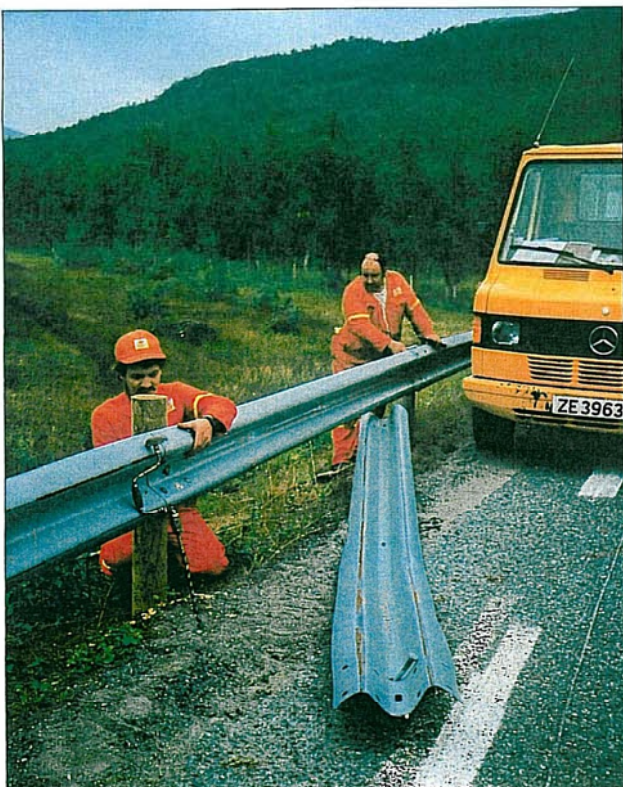
Trafikkrettet vedlikehold setter trafikantene i sentrum. Utskifting av nedslitte autovern er en del av vedlikeholdsarbeidet.
