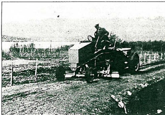
Drawn selvgående veghøvel fra 1929. Høvling av rv. 825 ved Finnfjordvann.
