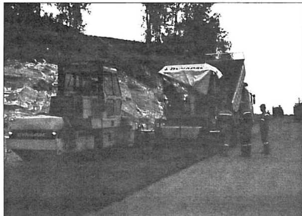
Dekkelegging på rv. 19.
