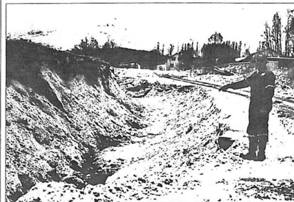
Naturen går sin egen vei- her har uvær og regn forårsaket flomskade på den nye parsellen av rv. 84 i Skøelv. Bjørnulf Johnsen betrakter skadene.
