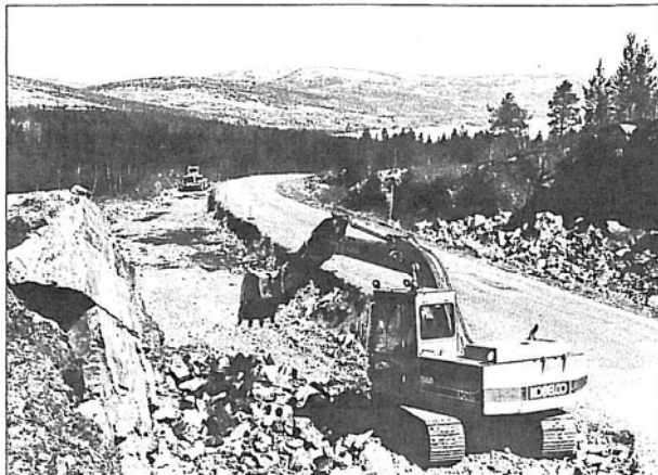
Strekninga Heia — Tømmerelv er nå i det nærmeste fullført. Her fra anleggsarbeid på Heia tidligere i år.
