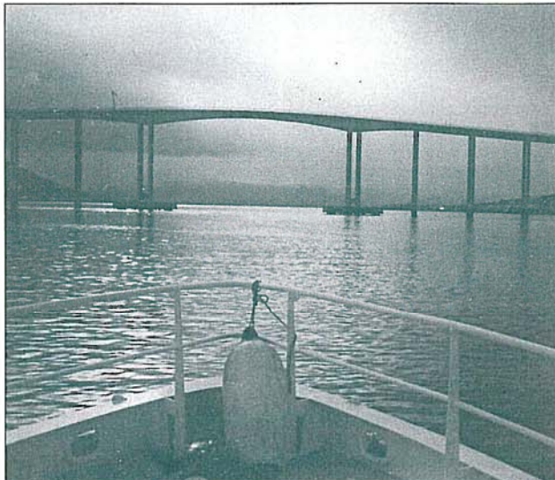
For å redusere muligheten for feilnavigering har brua nå fått montert et radarfyr midt i seiløpet under brubanen.
