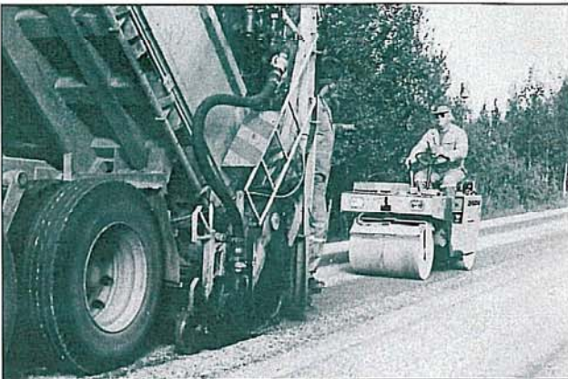
Kombisprederen på arbeidsoppdrag i Lavangsdalen.
