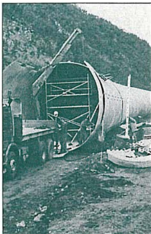
Monteringsarbeid. (Foto: Jan Floberg)
