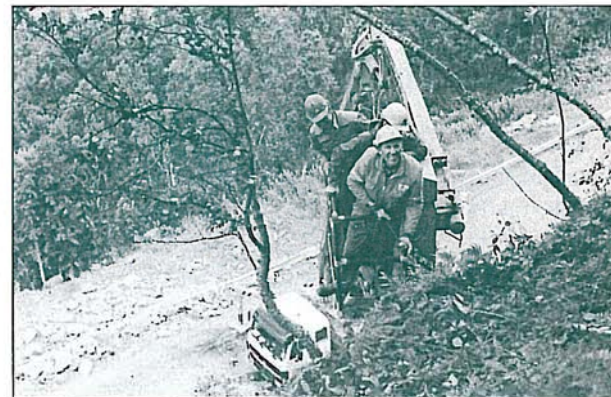
Sikringsarbeid i Turistlia — Gunnar Borch i forgrunnen.
