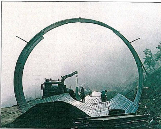
Et 170 m langt stålør inngår som en del av rassikring av Fjordgård.
