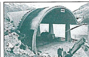
Eksempel på skredoverbygg – Pertisau, Achensee
