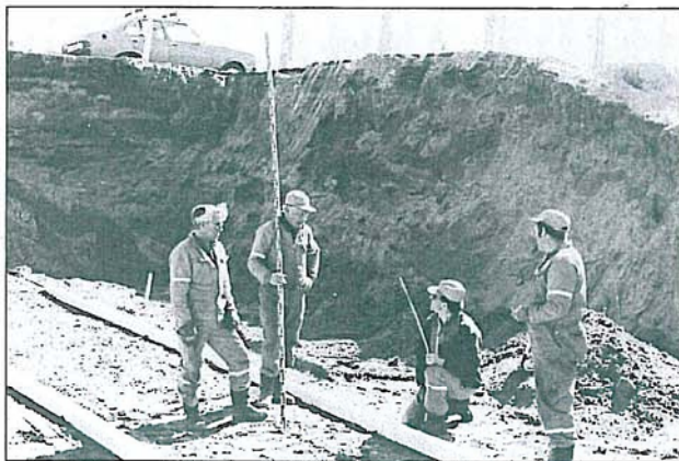
Det bygges undergang under E6 ved Olsborg. Her driver arbeidsgjengen med legging av elementene. Fra venstre Knut Eriksen, Helge Luneborg, Halvor Furnes og Arvid Andersen.
