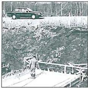
Bygging av undergang ved Tømmerelva.
