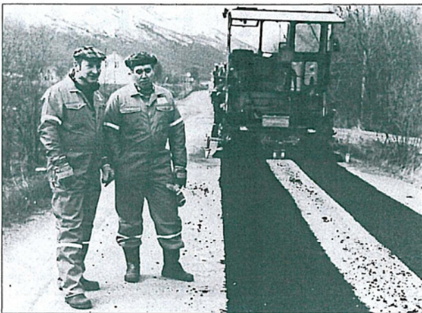
Fra prøveleggingen. Vi freser i striper sier Hans M. Figenschau og Hans Østerås.
