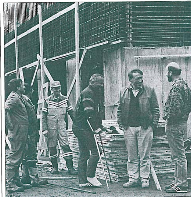
Tydeligvis ingen bekymring å spore hos «entreprenøren». Fra Sollia kuvert på rv. 860.
