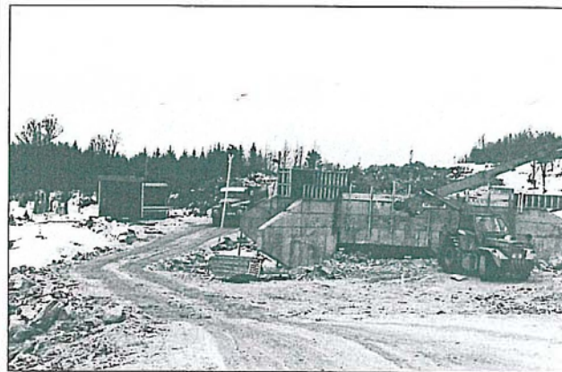
Stamvegnettet skal i størst mulig grad bli avkjørselsfri. Her oppnås en sikker kryssing av Rv. 19 ved bygging av egen undergang.
