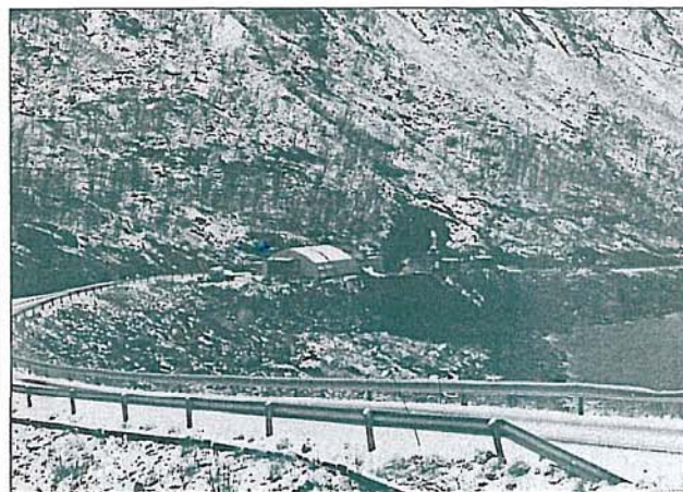
Tunnel til Fjordgård. Anlegget startet opp i oktober.
