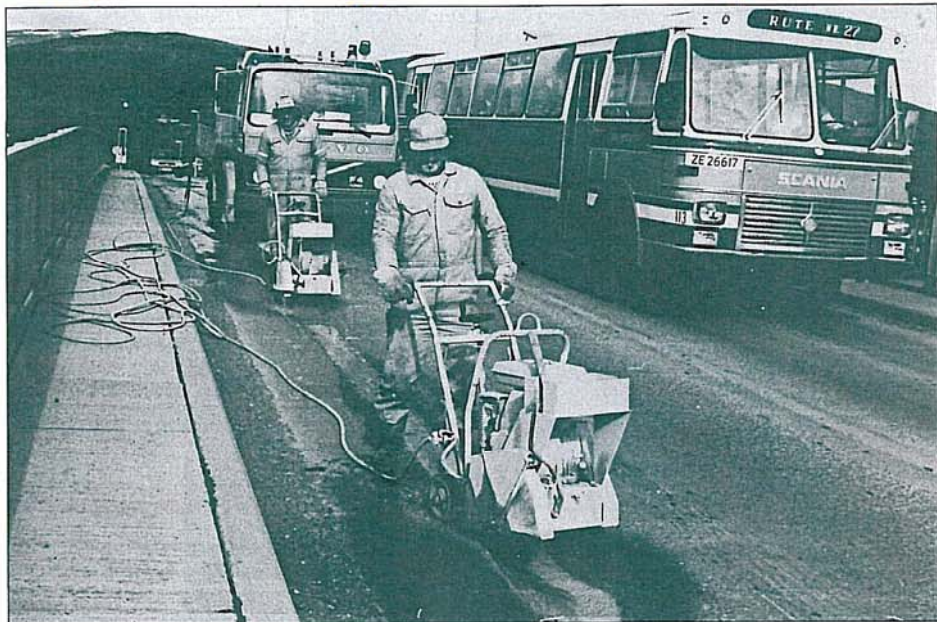
Betongsaging på Sandnessundbrua — Bakerst Hans Richardsen og fremst Ivar Ingebrigtsen.
