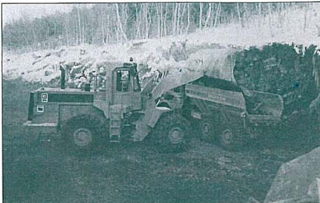
Vegvesenets «flaggskip» CAT-980 er i arbeid på innfartsvegen til Tromsø.
