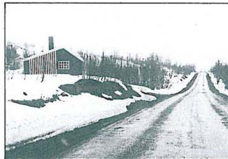
Velferdsbrakka i Svanelvdalen
