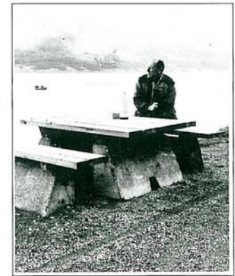
Treverket er boltet fast i kantstenene.
