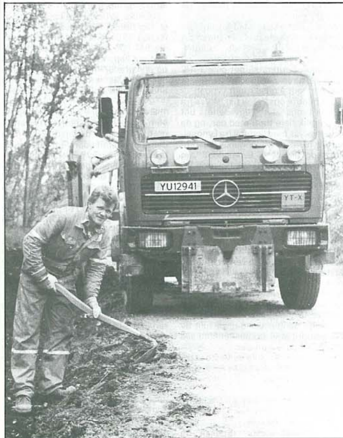
Stig Strømsør i arbeid på en av fylkesvegene, Ringvegen nord på Tromsøya.
