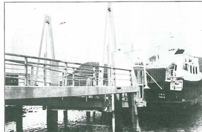
Et nytt ferjesamband ble åpnet i juli måned. Det var sambandet Bellvik-Vengsøy i Tromsø kommune. Vi har bygget to stålpelekaier, som tilsammen kostet ca. 8 mill kroner. Stålpelekaiene er forøvrig de eneste i Troms fylke.
