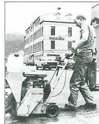
Svein Elsrud freser asfalten på Stakkevollvegen.
