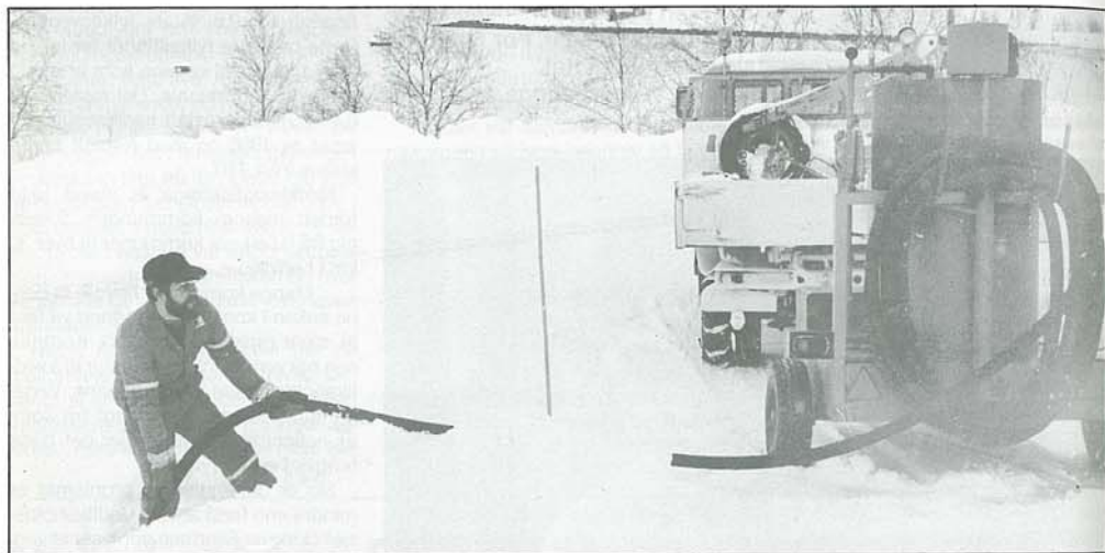
Vedlikeholdsfolkene skal også drive anlegg. Bildet viser vintervedlikehold på E-6 mot Storsteinnes.
