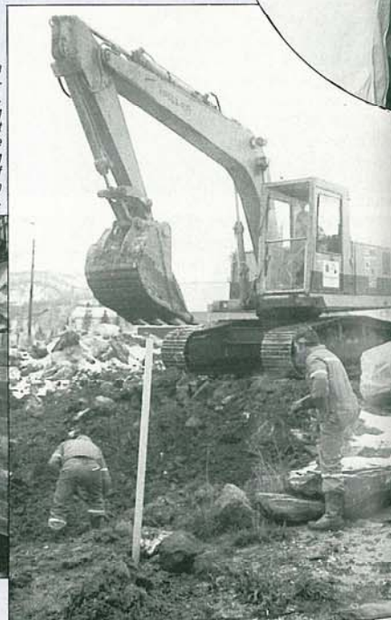
Fra Breivika — ny innfartsveg til Harstad. Vannledning blir sikret — Inge Andreassen og Alf Antonsen i arbeid.
