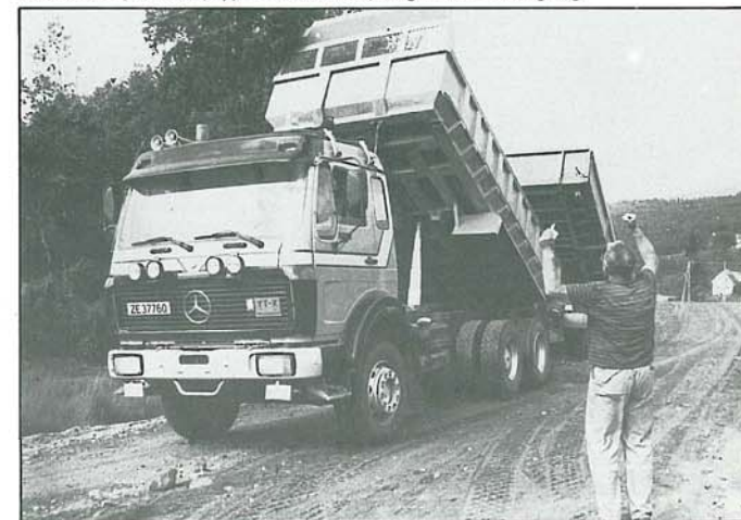
Toralf Olsen (sommerhjelp) kontrollerer utkjøring av forsterkningslag.
