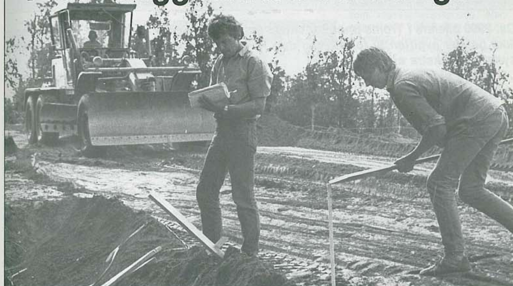
Det er travelt før dekkeleggingen. Oppsynsmann Thor-Inge Hole og Bjørn Tore Larsen (sommerhjelp) er opptatt med utstikking av vegkant.
