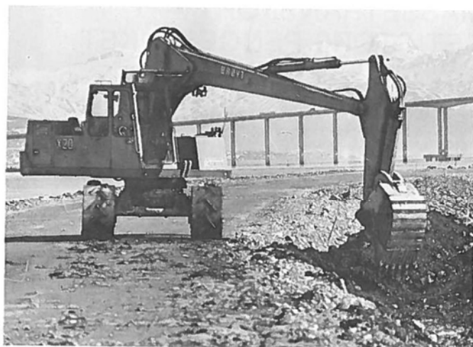
Vegen fram mot Tromsøbrua begynner å ta form — grøfter og skråninger ordnes.
