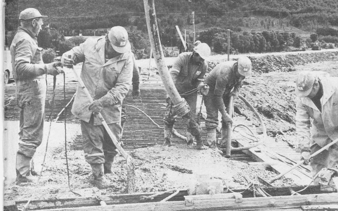
Frå dekkelegging av Vollan bru.
