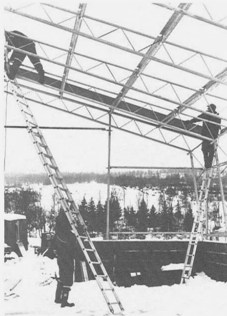
I monteringen — Roald Rasmussen, Ivar Iversen og Svein Markussen.
