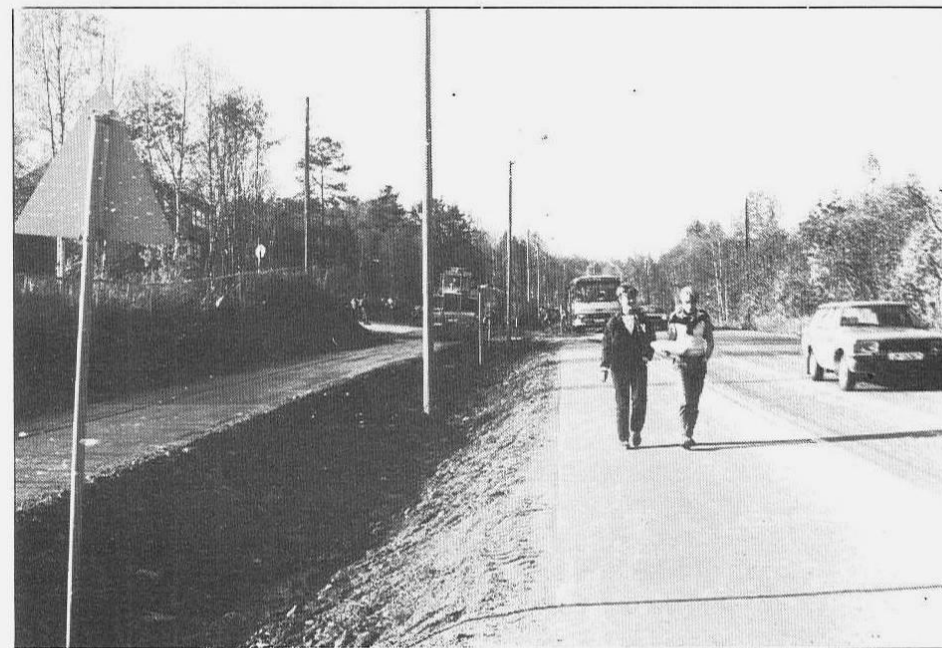
Rustadhøgda får nå gang-/sykkelveg som er adskilt fra E-6.
