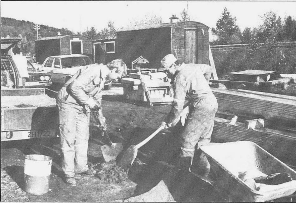
Tor Elverum og Tor Stenseth lager mørtel til gangbrua.
