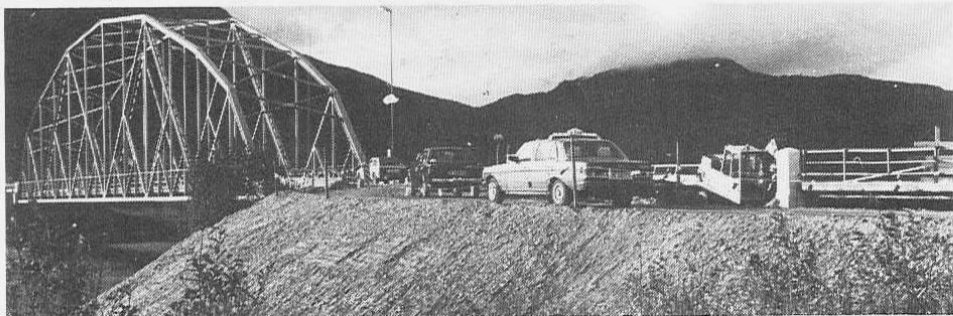
En solid fylling måtte til for at trafikken under arbeidet kunne gå over Nordreisa bru I. (Foto: Margit Pedersen).
