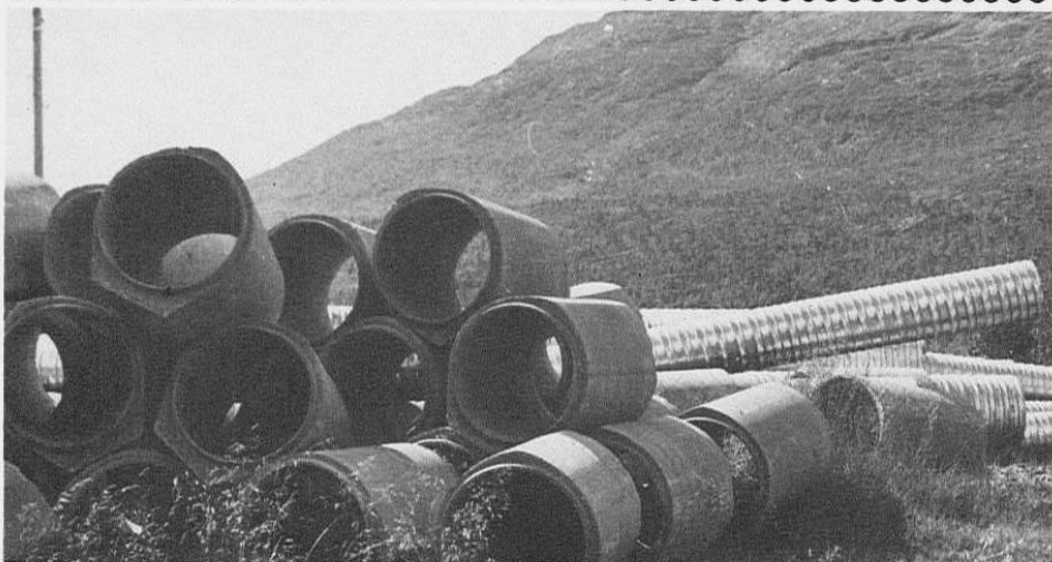
Betongrør og stålrør klar til bruk i Rv. 84.
