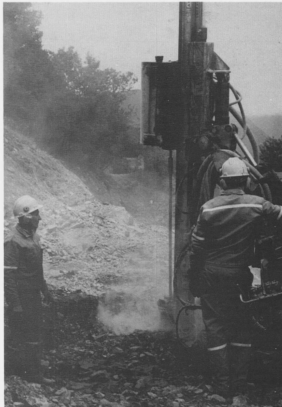
Rv. 850 Gåre – Refsnes er et av de anlegg som er forsinket – men vi er da godt igang, Albert Olsen og Johan Kristiansen.
