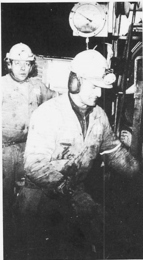
Arnulf Antonsen (bak) og Arne Johansen i betongblanding.
