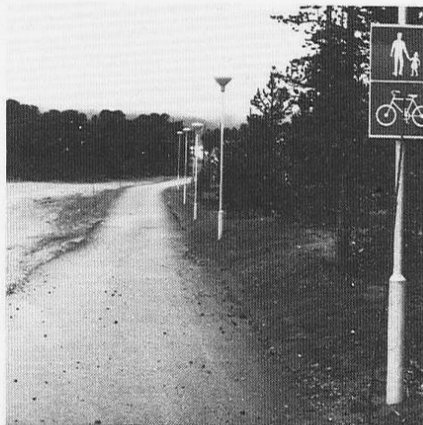
Bygging av gang- og sykkelveger er tiltak i trafikksikkerhetsarbeidet. Her fra nybygget gang- og sykkelveg i Skibotn med belysning og skjermet fra rv. 6 med furutrær.
