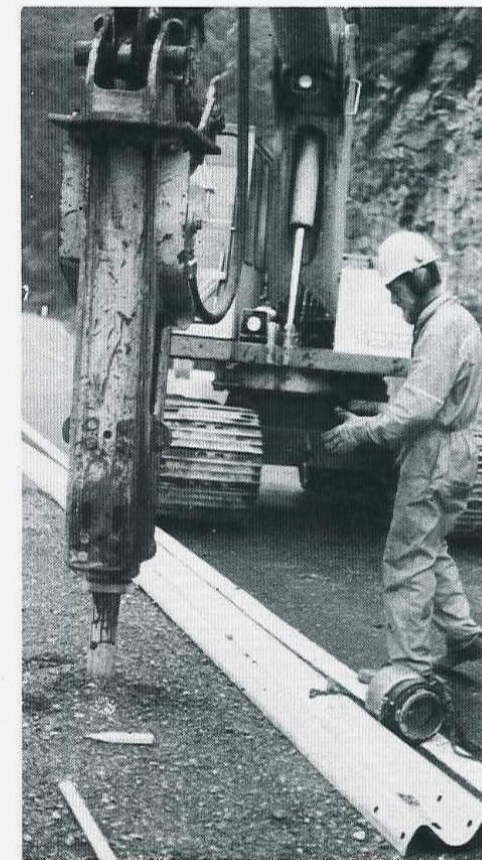
Gunnar Kvalberg – anleggsarbeider idag. Her i rekkverkoppsett.
