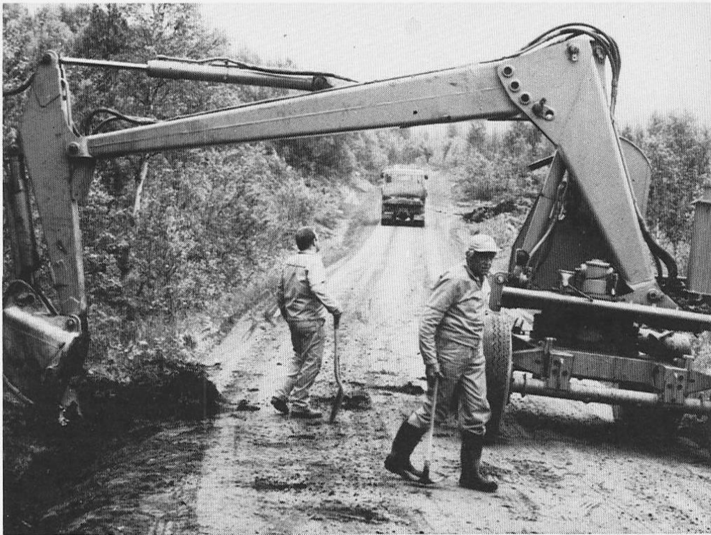
Riksveg 84 som dette bildet er hentet fra vil gjennomgå store forbedringer.
