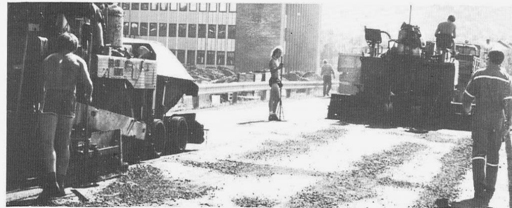
Gode vegdekker gir oljebesparelse. Her fornyes asfalten på E 78.
