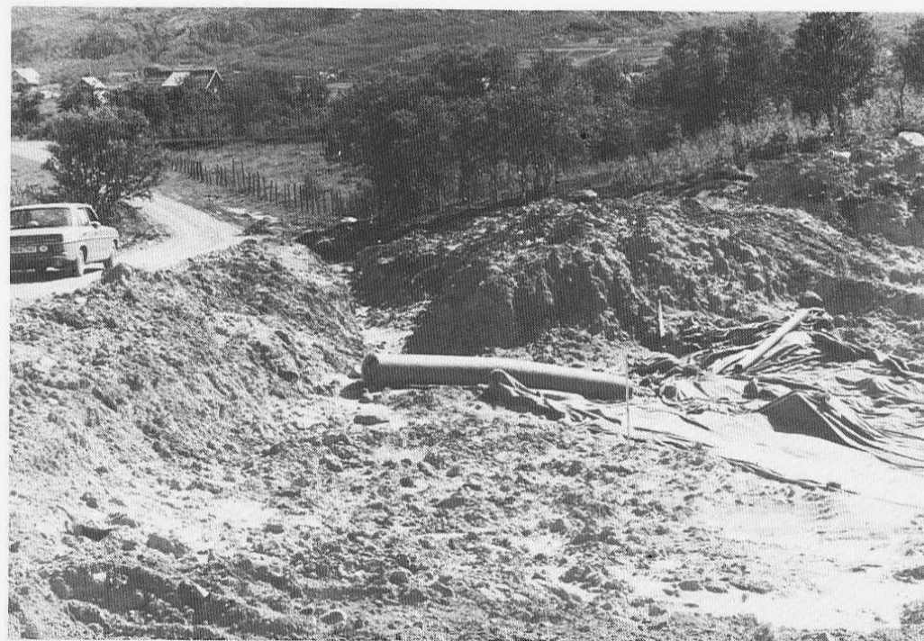
Det ble brukt fiberduk både i fylling og skråning for stabilisering av massene.
