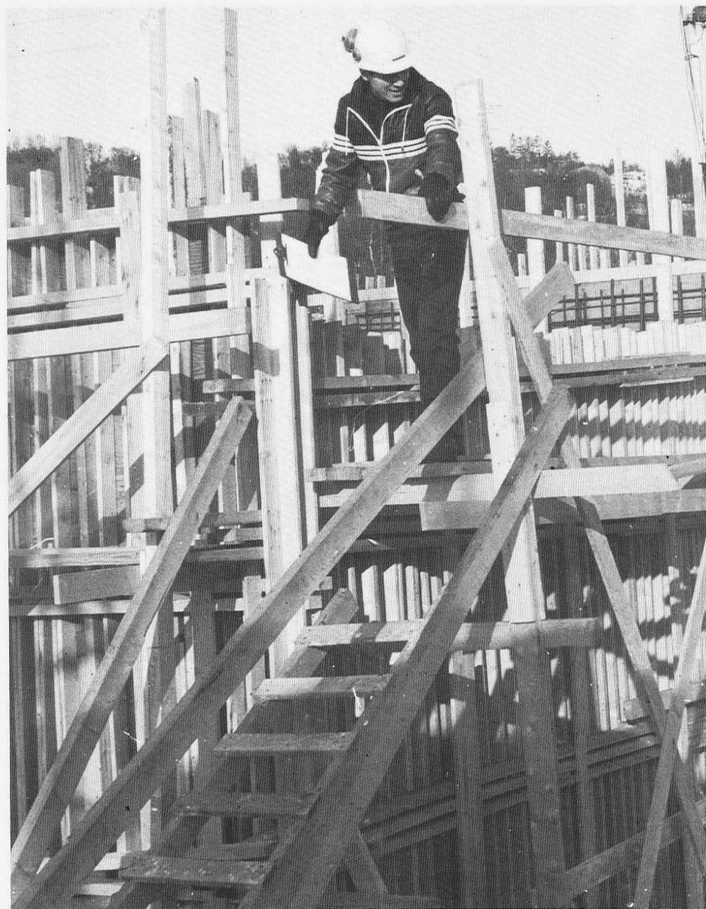
Arbeidsplassundersøkelser er kommet godt i gang. Vernelederen er her med blokk på et bruanlegg.
