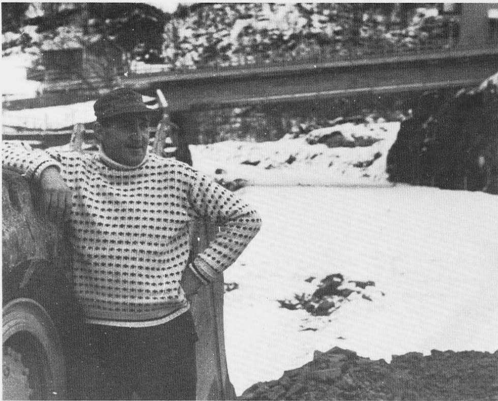
Og her er Langnesbrua på plass med Odd Marthinussen i forgrunnen, veteran på dette anlegget.
