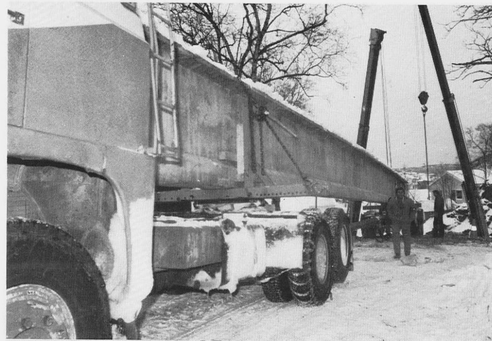
Solide bjelker i Langnesbrua som krevde kraftig kranhjelp.
