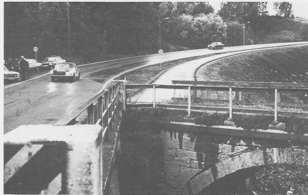
Ved Storsteinnes er E 6 omlagt og her ble bygget gang- og sykkelbane samtidig. Gamle Sagelv bru, som vi ser i forgrunnen, er innlemmet i gang- og sykkelbanen.
