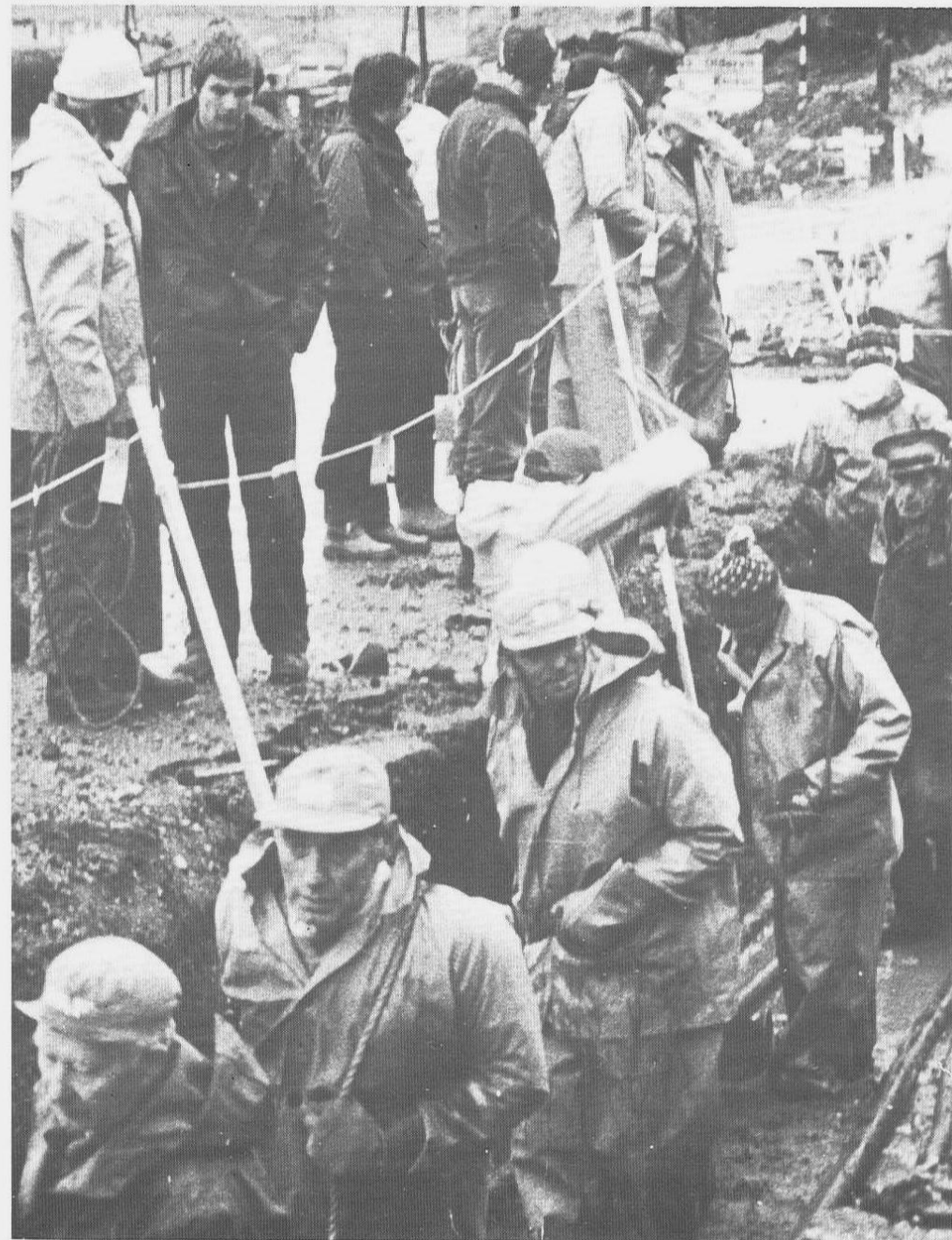
Her fra den store kabeldragerdag – Vegvesenet stilte med 50 mann og det måtte mobiliseres også fra vegkontoret.
