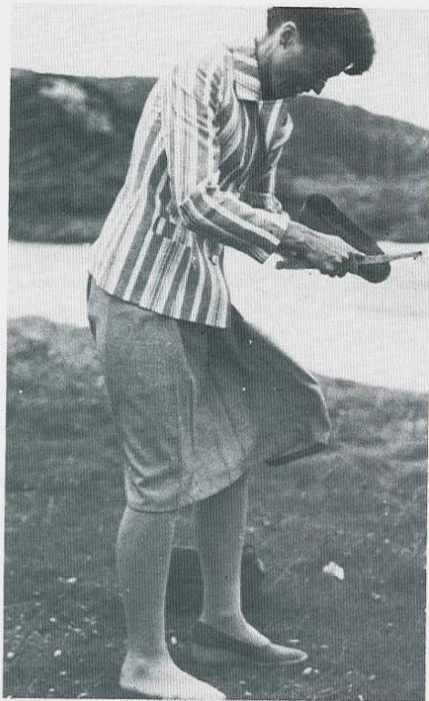
Ottadekket kan være lunefullt – det fikk Vilgunn Gregusson fra fylkesmannens kontor erfare under avleveringen av Sommarøy bru.
