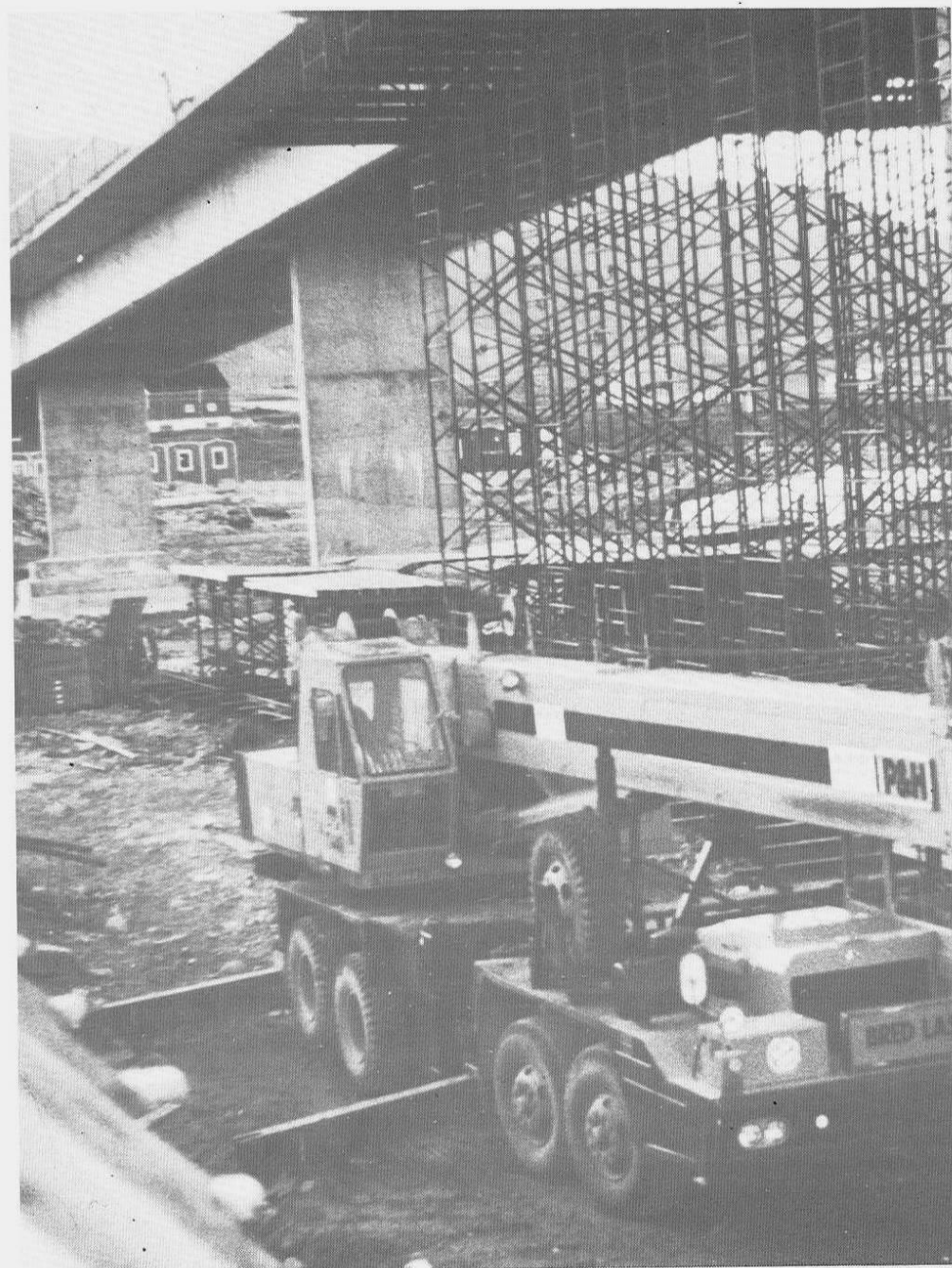
Brua tar form på Sørstraumensiden
