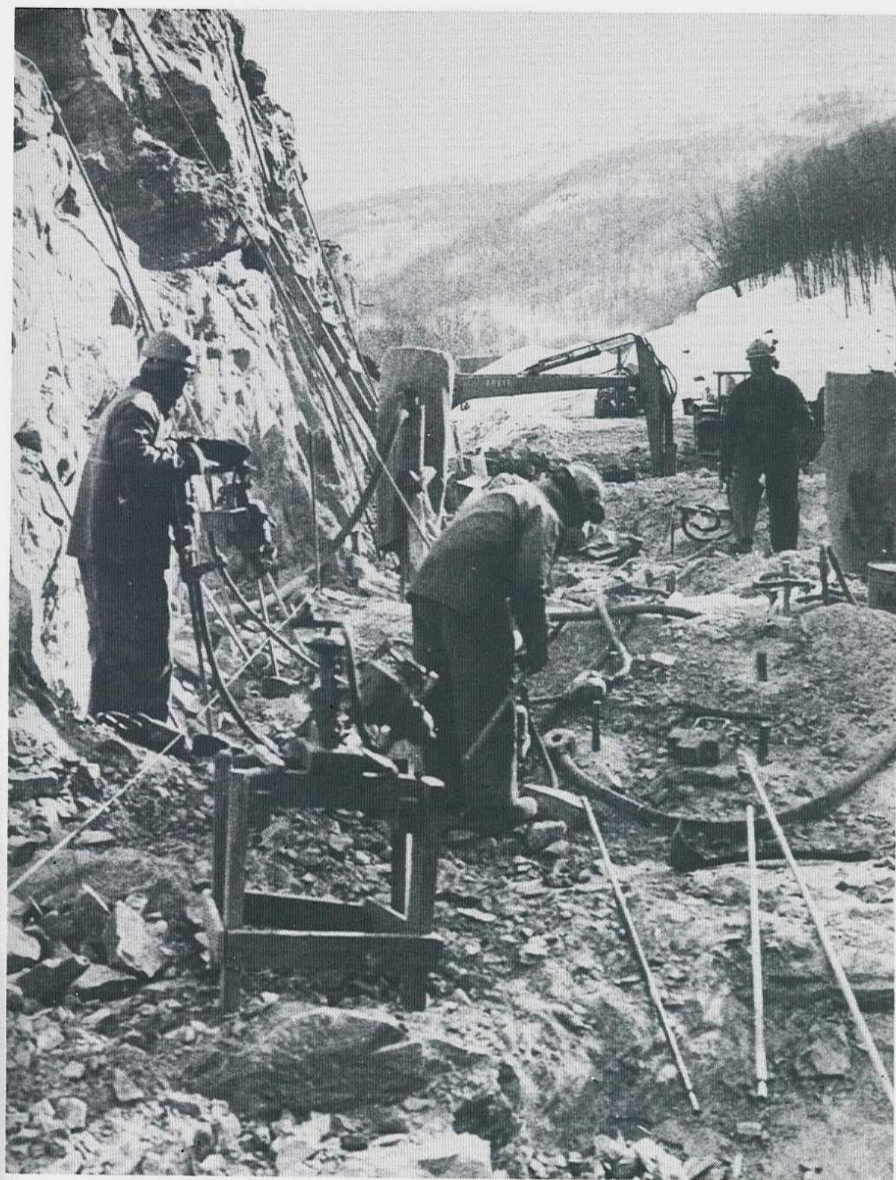
Fra storskjæringen – her nytter to og to boremaskiner felles støvsugingsanlegg – et ypperlig tiltak, sier brukerne.
