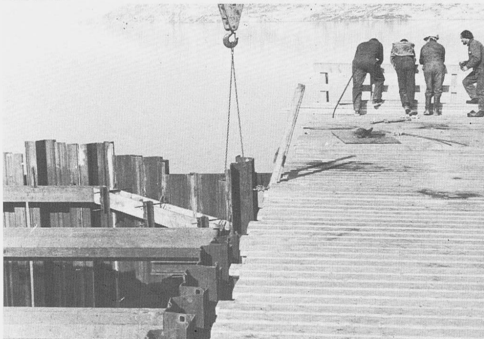
Vi ser deler av spuntveggene – solide konstruksjoner
