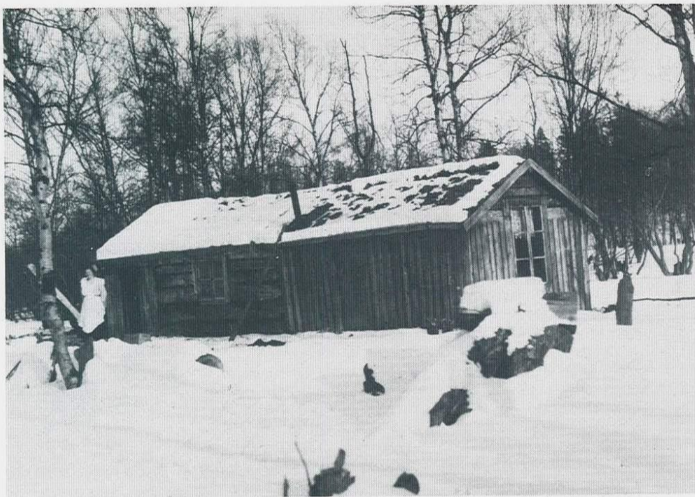
En brakke med kokka i positur under byggingen av Bergmo bru i Nordreisa i 20-årene.
