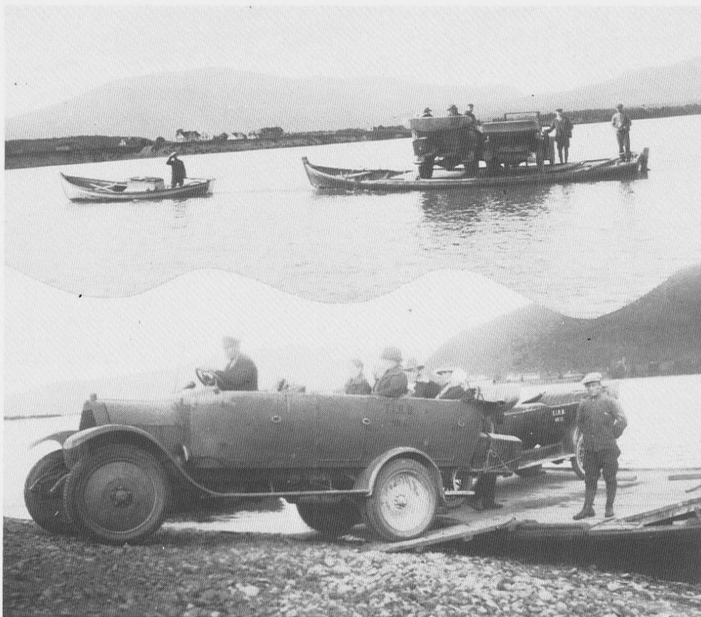
Overfart og ilandkjøring i 1928
