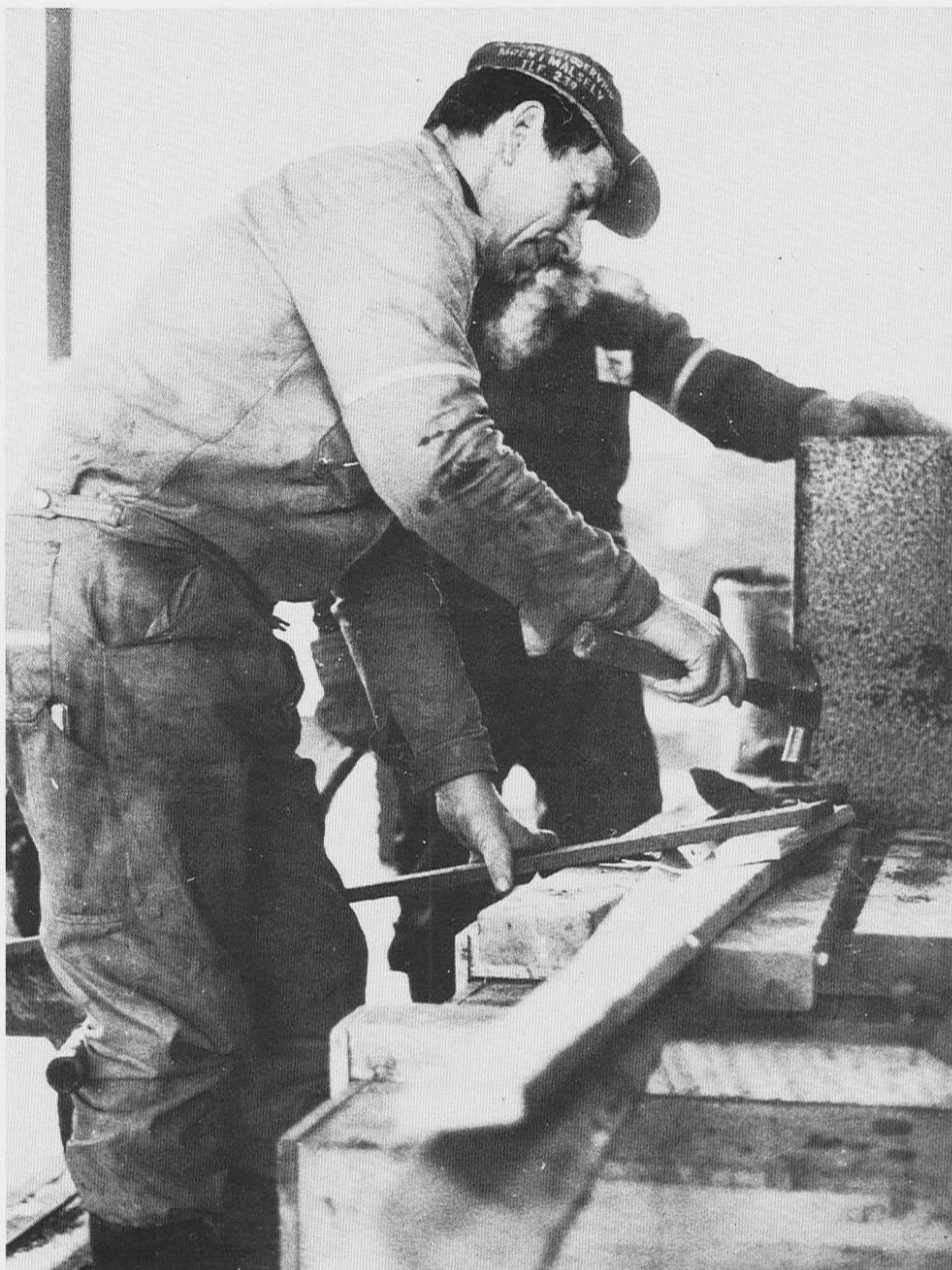
Tor Stenseth i jobb med vegvesenets nybygg på Finnsnes
