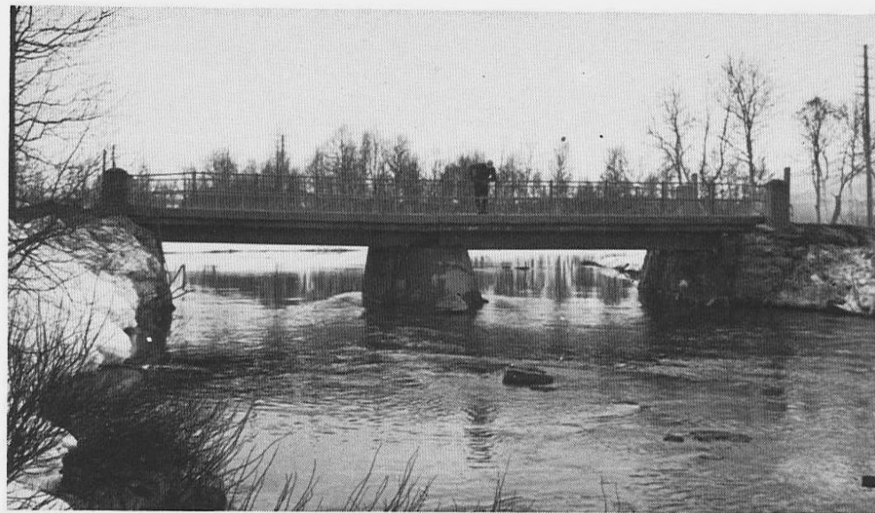
Øvre Lakselv bru i Rv 855 – bygging av ny igang.
