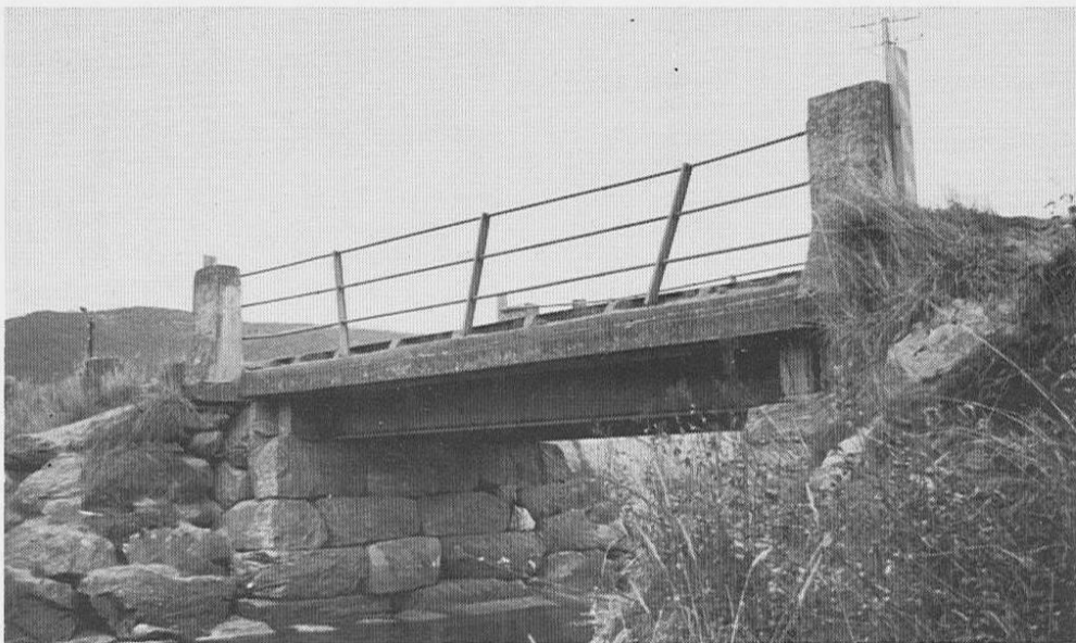
Ervik bru i Rv 867, ombygging snart ferdig.
