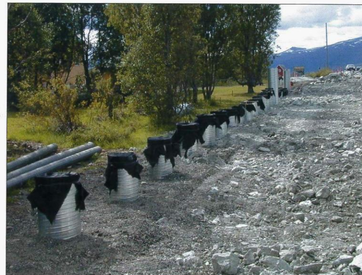
Fundamentene til støyvollene er sikret (tettet igjen)
