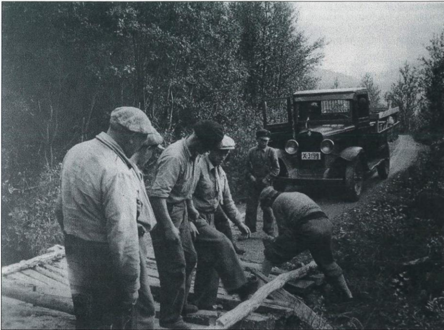
Reparasjon av bru i Skibotndalen i 1938.
