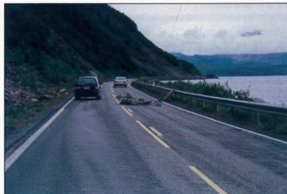
Steinras på E6 – like før Birtavarre. Selv om steinen var både flat og rolig da bildet ble tatt, hadde den vært i full aktivitet like før. Den ble fort fjernet av vegvesenet.
