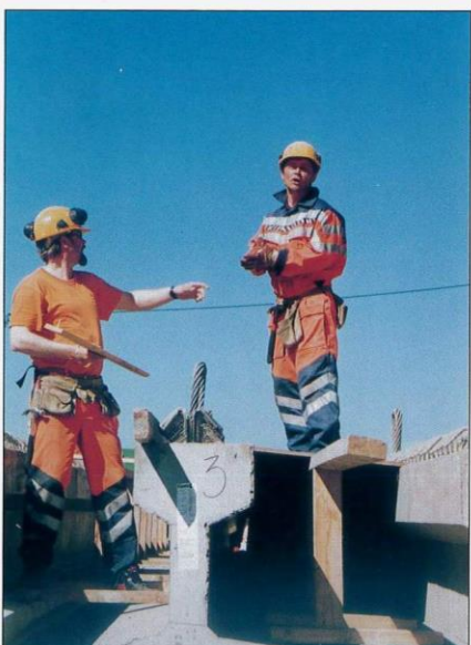
Dag og Terje – "heftige" betongarbeidere.
