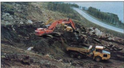
Graving og transport av masser ut fra forskjæringen på Bånes.
